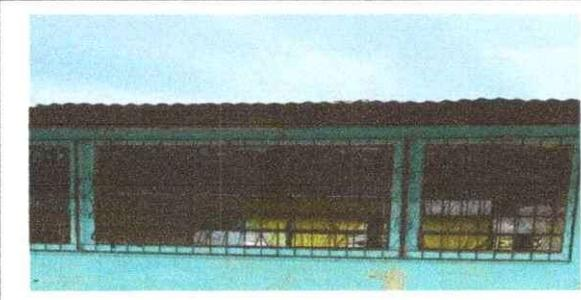
Foto 6: Mantenimiento de balcones lijado y pintado
