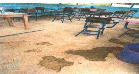
Foto 3: Mantenimiento de piso rustico a piso alisado
