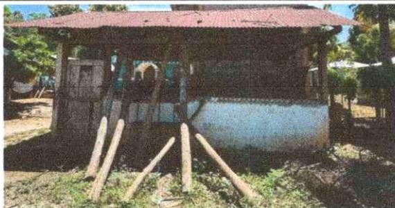
Foto 5: cambio de lamina y puerta de madera a por metal modulo 02 cocina
